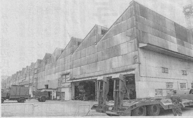
三菱重工業熊本航空機製作所の組立工場だった建屋。採光のため屋根はギザギザ形になっている＝熊本市の陸自健軍駐屯地
