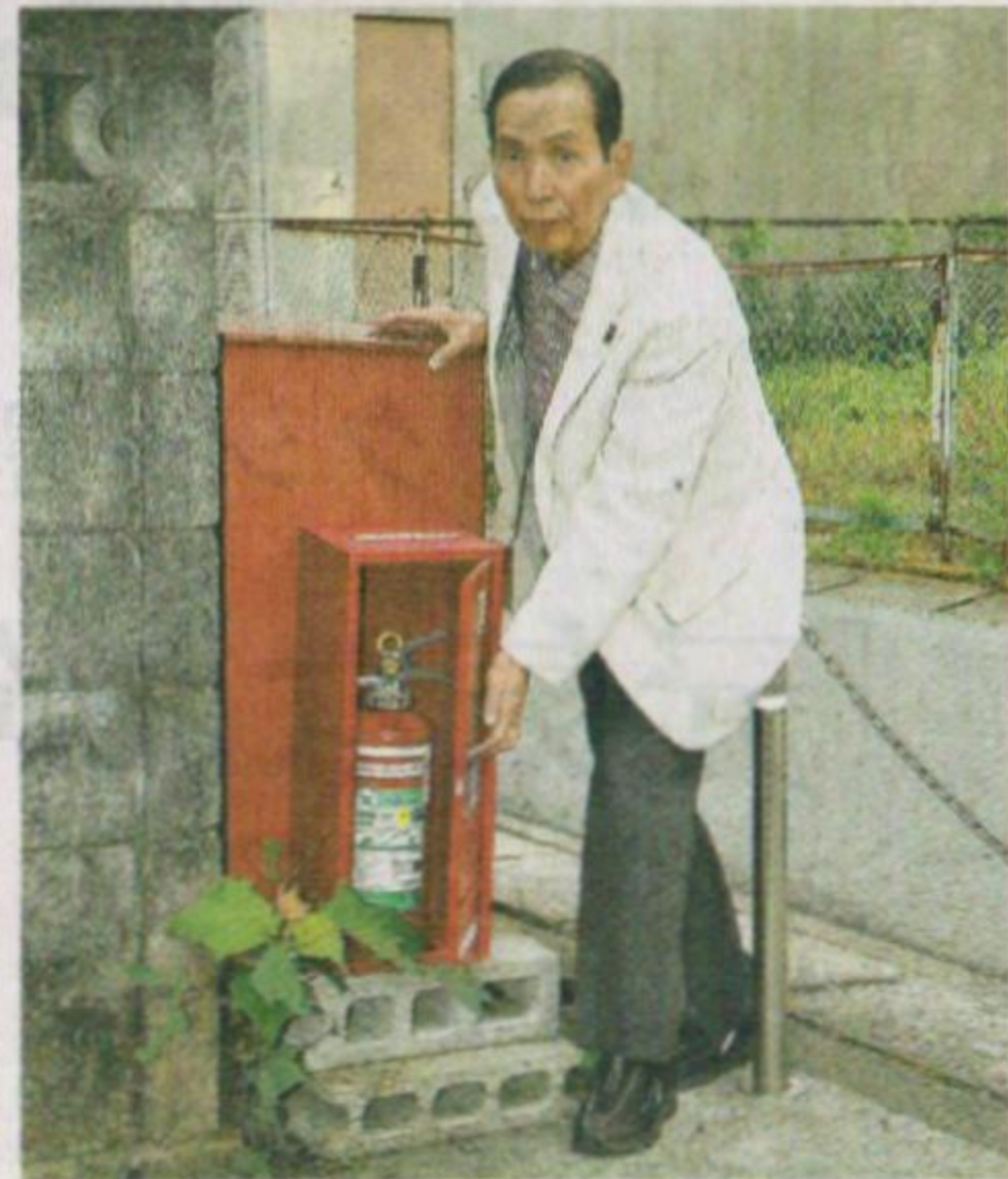
道路脇に設置された消火器の前に立つ高橋校区自治会の鴻池紘会長 =熊本市西区高橋
